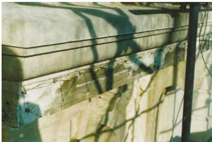
inoxidável, fixados por parafusos do mesmo material, constituindo um tipo de armadura de pele.
